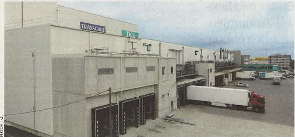
Neubau: Vollautomatisches Tiefkühl-Hochregallager für 7.500 Palettenplätze
